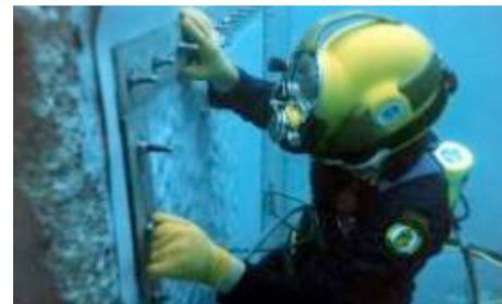
Déroulement, positionnement et fixation de la géomembrane SIBELON® sous l'eau
