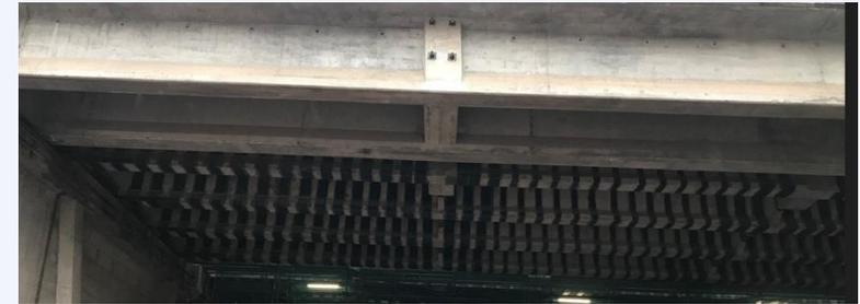
*Renforcement des poutres du viaduc du Reyran / Escota*
