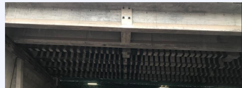
Refuerzo de vigas del viaducto de Reyran / Escota
