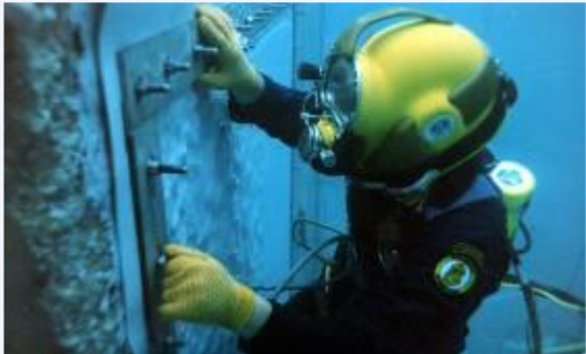
Desenrollar, posicionar y fijar bajo el agua la geomembrana SIBELON®
