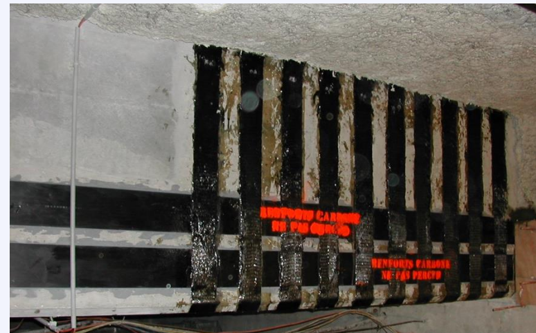
Refuerzo de vigas en estructura ocupada/ Cité de la musique
