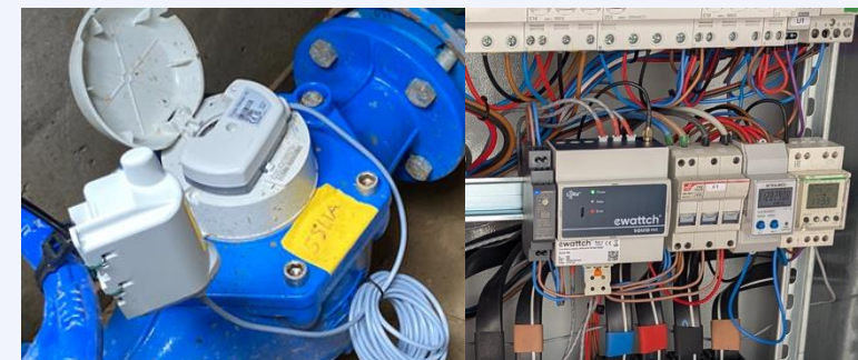
Contadores comunicantes agua y electricidad
